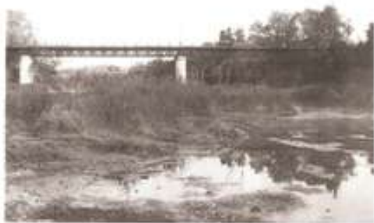
PONT ROUGE à ROSIÈRES
