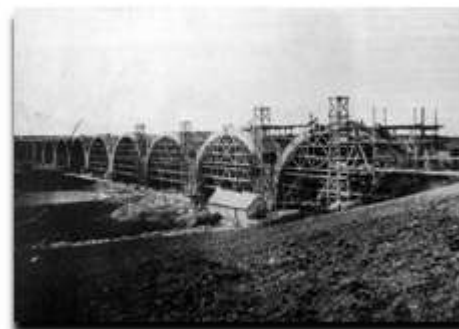
Construction du viaduc
